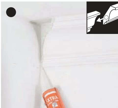
Verwenden Sie DecoFix Extra bei jeder Naht. Verwenden Sie Spachtelmasse um die Stoßstellen zu spachteln
