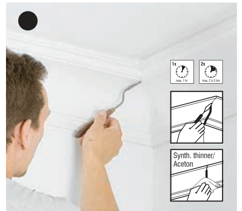
Überschüssigen Kleber vor dem Aushärten mit einer Spachtel entfernen durch Abziehen (nach 1 Std und nach 2-3 Std. wiederholen)
