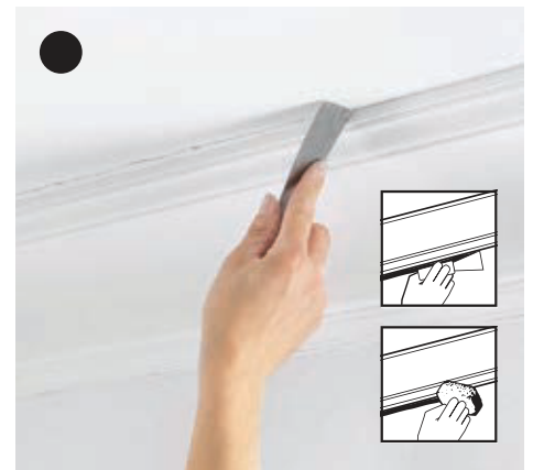
Entfernen von Überschuss DecoFix Pro: Mit Feuchtem Schwamm DecoFix Power: Seifenlösung
