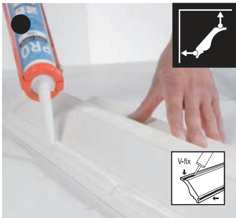
Tragen Sie den Kleber in die V-Fugen entlang des Profiles auf
