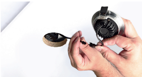
4 - Verbinden des Netzgeräts mit dem Spot mittels Steckverbinder
