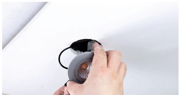
5 - Einsetzen des Spots in den Deckenausschnitt
