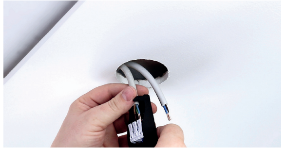
1 - Schnelle Verkabelung / Durchgangsverdrahtung an der Quick-Anschlussbox durch schraublose Steckklemmen
