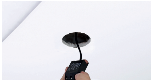
3 - Kompaktes Netzgerät wird in den Hohlraum eingeschoben
