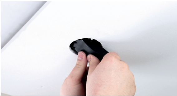
2 - Quick-Anschlussbox wird über den 68-mm-Ausschnitt im Hohlraum platziert
