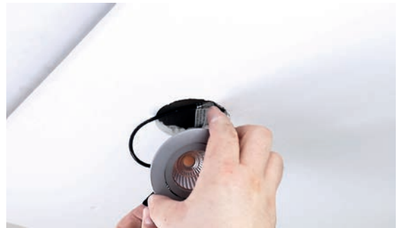
5 - Einsetzen des Spots in den Deckenausschnitt
