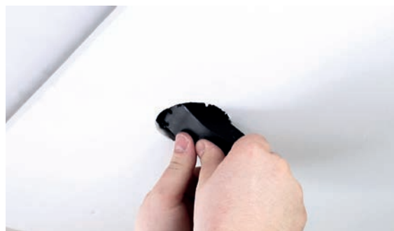
2 - Quick-Anschlussbox wird über den 68-mm-Ausschnitt im Hohlraum platziert
