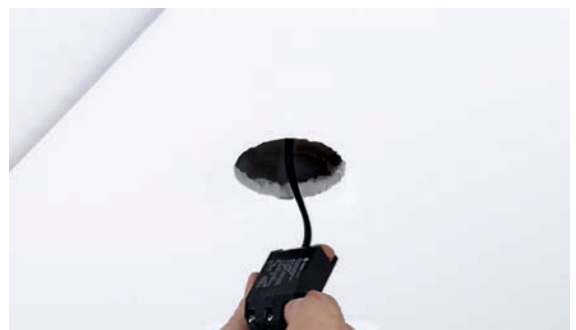
3 - Kompaktes Netzgerät wird in den Hohlraum eingeschoben
